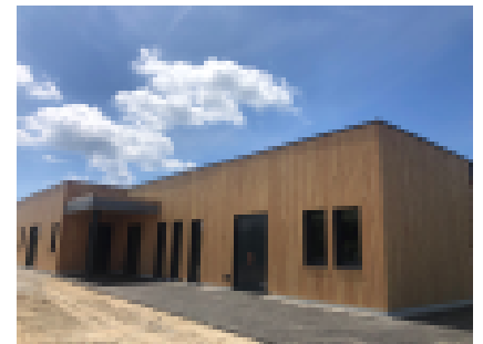
Bâtiment de la nouvelle crèche en construction
